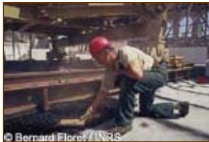
Pose de revêtement bitumineux dans le bâtiment
