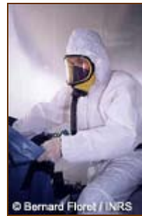
Tenue d'intervention en zone confinée de désamiantage
